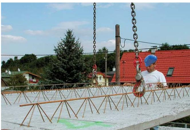
Bild 13: Einheben eines Deckenelementes
