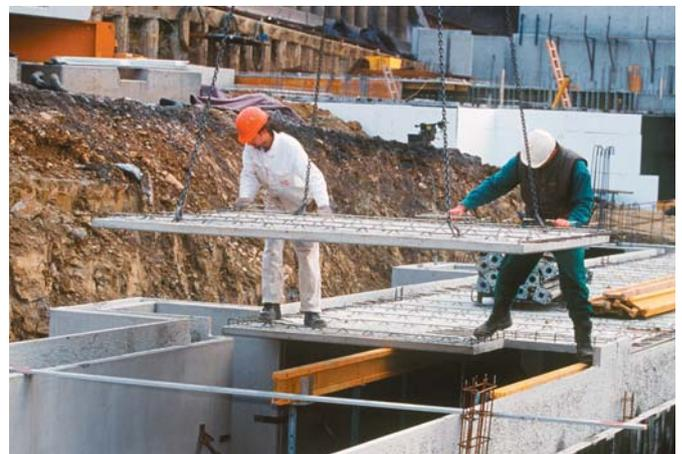
Bild 15: Verlegen der Deckenelemente
