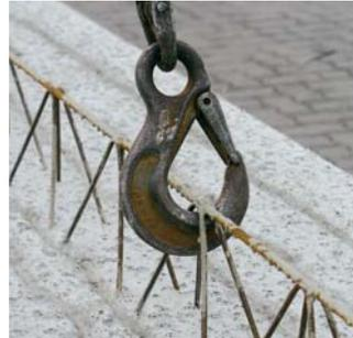
Bild 5: Kranhaken in Knotenpunkten der Gitterträger einhängen
