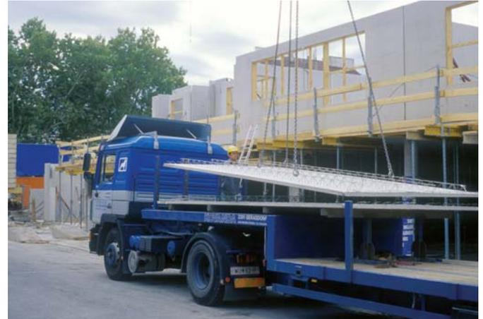
Bild 14: Abladen der Elemente
