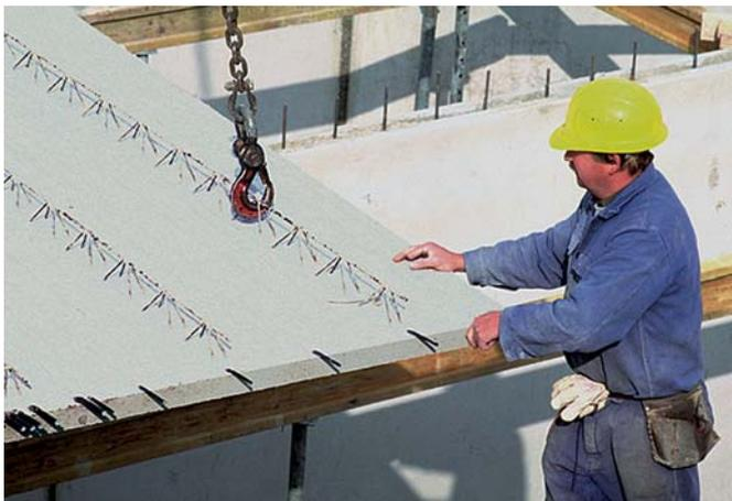
Bild 12: Verlegen der Deckenelemente
