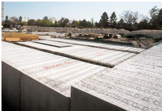
Bild 16: Fertig verlegte Elementdecke
