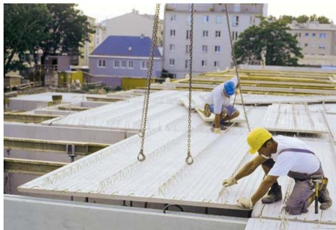
Bild 8: Verlegen der Deckenelemente
